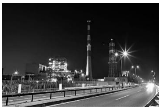
③ 火力発電所
