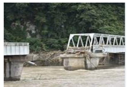
流失した人吉市県道15号西瀬橋
